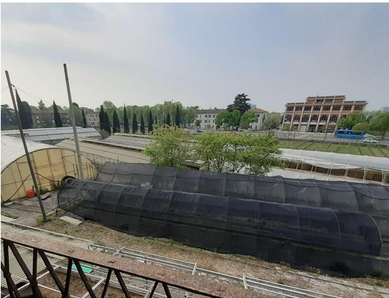
La struttura portante della serra è costituita da una base di calcestruzzo su cui poggia uno scheletro di acciaio ricoperto da vetro e da un materiale simile alla plastica, il polietilene che, trasparente, permette il passaggio della luce e nello stesso tempo trattiene il calore. Questo fenomeno si chiama effetto serra e permette di mantenere un clima adatto a coltivare
